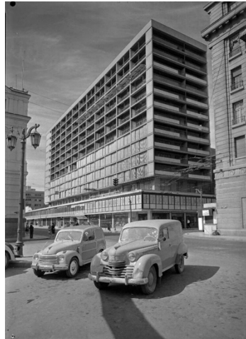
Figura 4. Galería comercial y edificio Plaza de Armas
